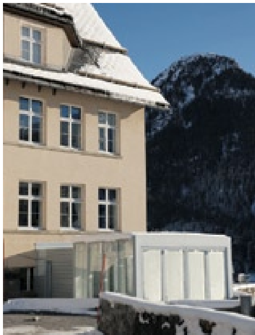
In ihrem 2006 neu erstellten Haus bleibt die Weltstandardgruppe fest an ihrem Standort. Zum Messen wird die Front geöffnet und der vordere Teil des Hauses zurückgefahren
