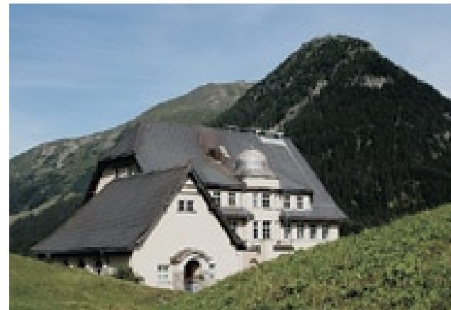
Standort des PMOD/WRC heute: Altes Schulhaus Davos Dorf
